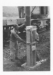
A l'extérieur, à gauche: La grue soulève le poteau, l'enlève du wagon et les monteurs le reçoivent pour le fixer (à gauche) dans la cavité bétonnée.
