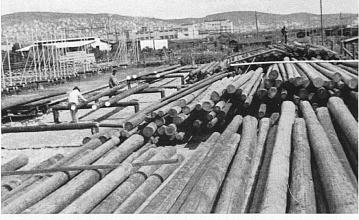
En haut: Une partie de la gare aux marchandises de Zurich s'est transformée en chantier où les charpentiers taillent les troncs d'arbre pour en faire des pylônes. — En bas: La préparation soignée de ces poteaux permet un montage plus rapide. S'ils sont bien adaptés, ils auront une meilleure assise dans le socle de béton.
