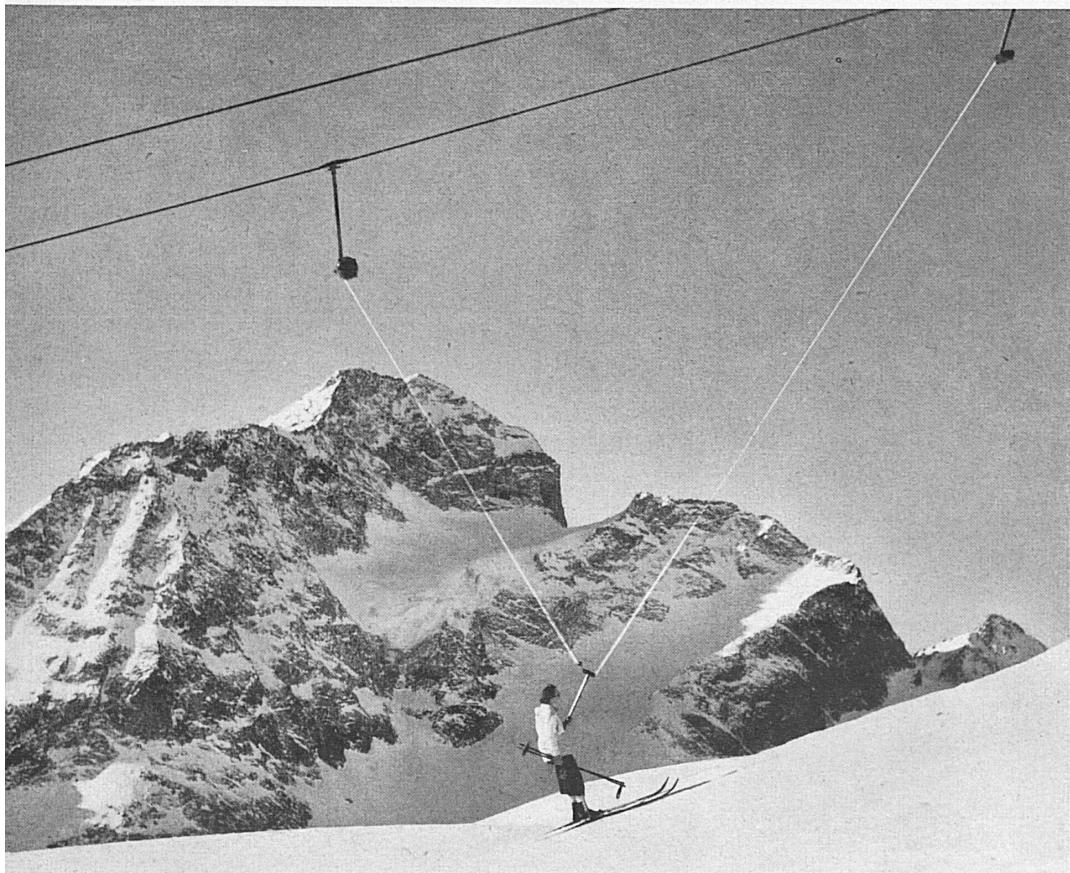
Die Skilifts der Zentralalpen, der Ostschweiz und Graubündens sind meist nach den Systemen Constan oder Oehler erstellt, bei denen jeder Bügel zweifach an dem endlosen Zugseil befestigt ist. Beispielsweise ist es bei den Anlagen von Stoos nach dem Fronalpstock (oben) oder von St. Moritz-Suvretta nach dem Piz Nair (links) der Fall.\*
