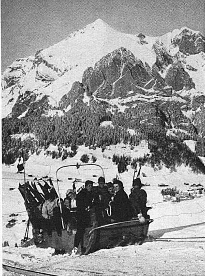
An mehreren Orten, so in Wildhaus (links), sind Seilschlitten im Gebrauch, welche in der nämlichen Weise wie die Drahtseilbahnen verkehren. — Auch der Strelalift ob Davos (rechts) verkehrt nach dem System Constat. — Der Skilift von Bretaye nach Chaux-Ronde in den Waadtänderalpen (unten rechts) wird dagegen nach einem nur ihm eigenen Spezialsystem (System Siebenthal) betrieben, indem die Bügel direkt und nur einfach am Zugseil hängen.\*
