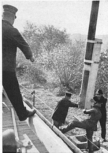
Links: Die Holzmasten werden auf einen speziellen Materialwagen verladen, um am vorgeschriebenen Platz aufgestellt zu werden. — Rechts: Der Stellvertreter des Bahnmeisters dirigiert das richtige Maststellen.
