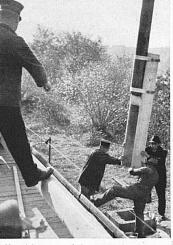
Links: Die Holzmasten werden auf einen speziellen Materialwagen verladen, um am vorgeschriebenen Platz aufgestellt zu werden. — Rechts: Der Stellvertreter des Bahnmeisters dirigiert das richtige Mastenstellen.
