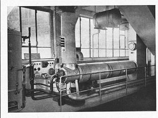
Warmluft-Heizung mit SAG-Gasgenerator
