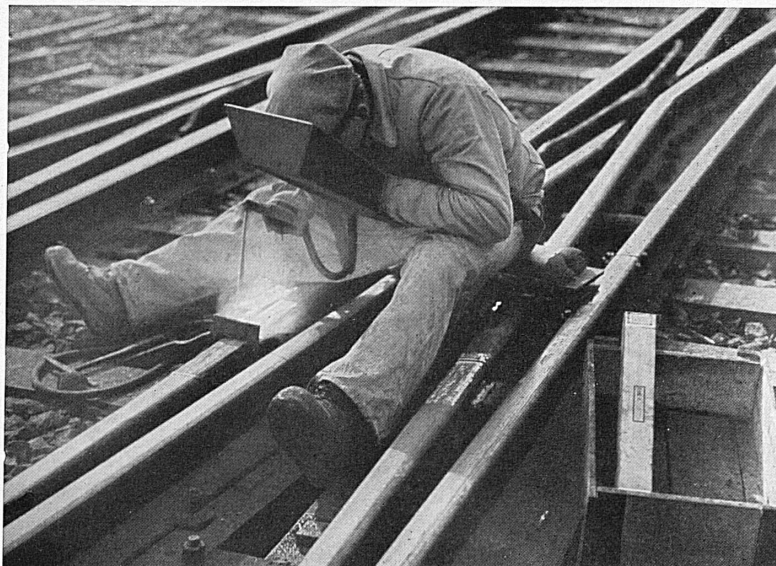
Unterhalts-Schweißarbeiten in einem SBB-Bahnhof
