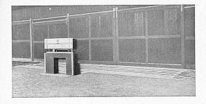
40 Tonnen Waggon-Waage mit Geleiseunterbrechung mit armierter Betonbrücke in Rippenkonstruktion, pat. Auffahrrampen, torsionsfreiem Hebelwerk mit pat. verstell- und auswechselbaren Schneiden. 2944 WAAGEN ALLER ART
