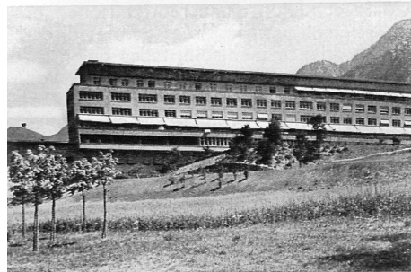
A gauche: Sanatorium de Bella Lui à Montana, en Valais (1930). — Hôpital cantonal rhétique à Coire (1941). A droite, de haut en bas: Observatoire, Station de recherches hautes-alpines et Hôtel du Jungfraujoch, 3500 mètres au-d. de la mer. — Appareil actinométrie à l'Observatoire de Davos. — Une opération à l'hôpital cantonal de Coire. — La guérison par le travail à la Clinique-manufacture internationale de Leysin.
