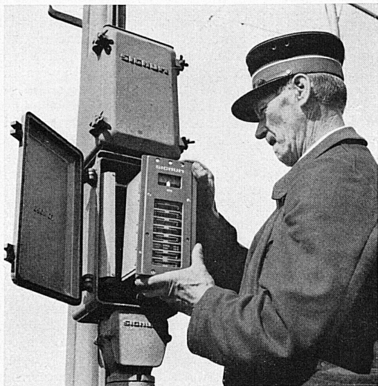
Ein leicht auswechselbares polarisiertes Relais steuert über zwei Kabelleitungen die drei Begriffe « halb, gerade Fahrt und ablenkende Fahrt » am Lichtvorsignal und stellt die Verbindung mit den Geleisemagneten der automatischen Zugsicherung her.
