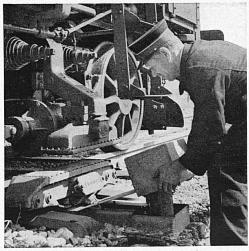
${\it \leftarrow}$  Gleis- und Lokomotiv magnet  ${\it \succ}$  übertragen die Signalstellung auf den Führerstand.
