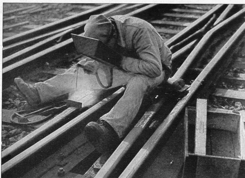
Unterhalts-Schweißarbeiten in einem SBB-Bahnhof
