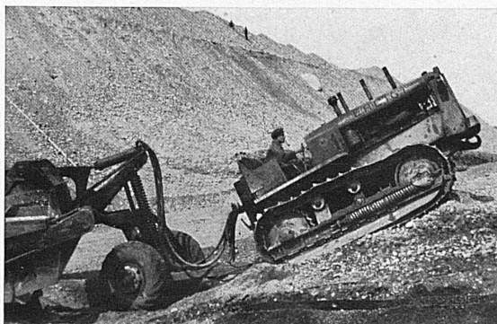
Train de scrapers, 120 CV., 22 tonnes. Chantier Lonza, Viège.
