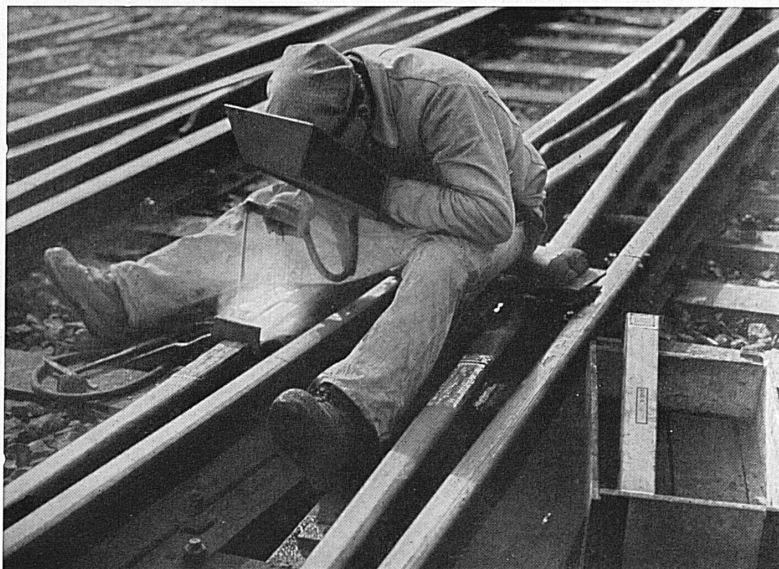
Unterhalts-Schweißarbeiten in einem SBB-Bahnhof
