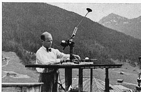
Deux solarimètres thermo-électriques pour l'enregistrement du rayonnement total du soleil et du ciel, l'un protégé de la radiation directe par un écran.
