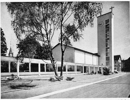
AUSGEFÜHRTER KIRCHENBAU IN EISENBETON
