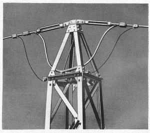
Zwischenabspannung einer ausgeführten Weitspann-Fernsteuer-Luftkabelanlage eines schweizerischen Großkraftwerkes.
