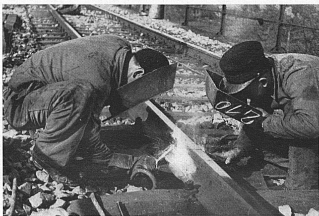
Elektrische Schienenstoß-Schweißung in einem Hauptgeleise der SBB.
