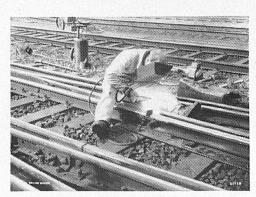
Unterhalts-Elektro-Schweißarbeiten an Weichenanlagen in einem SBB-Bahnhof.
