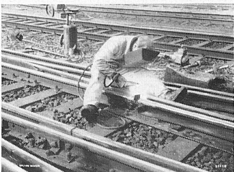
Unterhalts-Elektro-Schweißarbeiten an Weichenanlagen in einem SBB-Bahnhof.
