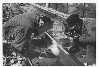
Elektrische Schienenstoß-Schweißung in einem Hauptgeleise der SBB
