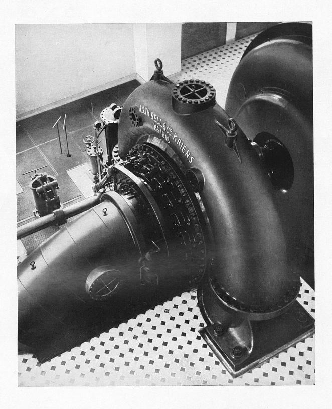
Eine der beiden 22750 PS-Francis-Spiral-Turbinen im Kraftwerk Unteraa der Zentralschweizerischen Kraftwerke
