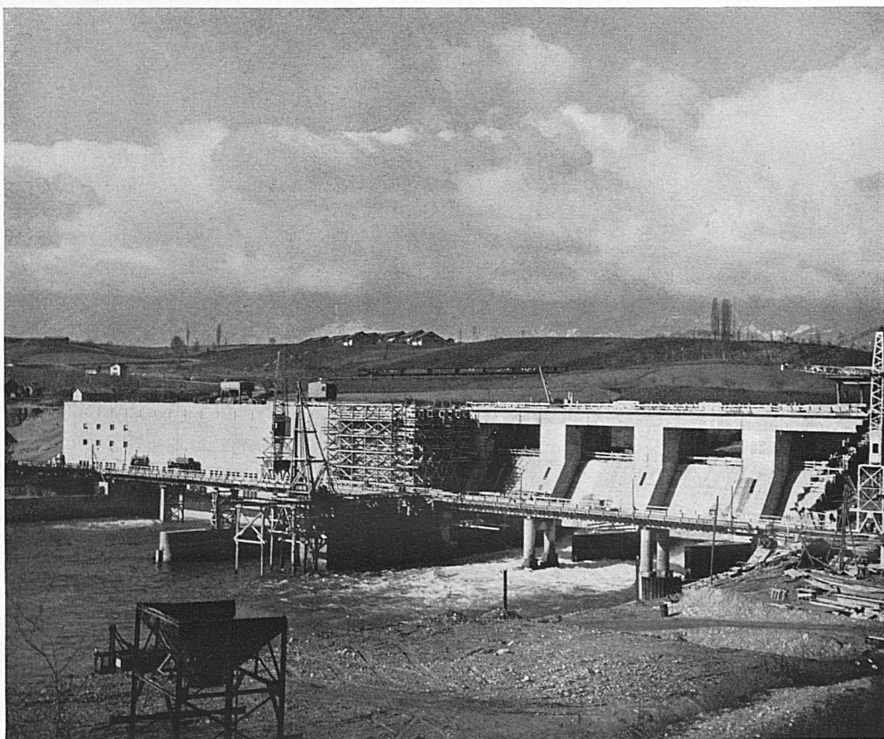
Le barrage du Verbois vu de l'aval. A droite: Les passes et les vannes; à gauche: L'usine. Verbois, von der Unterwasserseite her gesehen. Rechts die Wehranlage, links das Maschinenhaus.*
