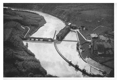
Le barrage du Verbois vu de l'aval. A droite: Les passes et les vannes ; à gauche: L'usine. Verbois, von der Unterwasserseite her gesehen. Rechts die Wehranlage, links das Maschinenhaus.\*
