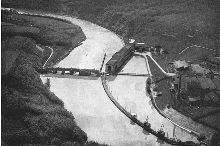
L'usine de Chèvres, l'ancêtre des usines dites « au fil de l'eau ». Chèvres, das Urbild der Flußkraftwerke.*
