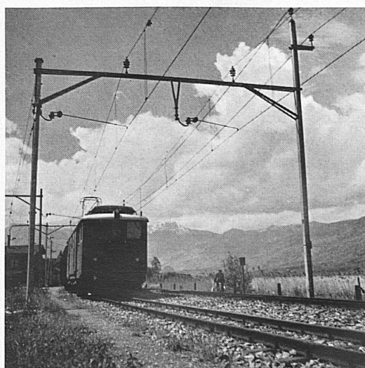
Auch die Brüniglinie ist nun ebenfalls elektrifiziert.* La ligne du Brünig elle aussi a été électrifiée.
