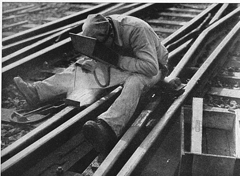
Unterhalts-Schweißarbeiten in einem SBB-Bahnhof
