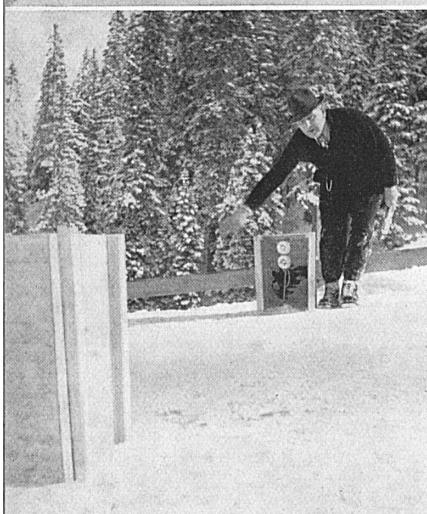
Die Einrichtung des oberen Meßpunktes — 40 m oberhalb des Schanzentisches — wird installiert. Sie besteht aus zwei Lampen, die quer über die Anlaufbahn einen Lichtstrahl senden, der auf der anderen Seite von einer Photozelle aufgefangen wird. Im Augenblick der Durchfahrt des Springers wird er unterbrochen: der Chronometer beginnt zu laufen.
