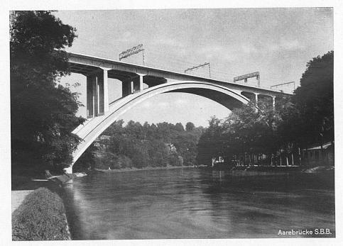
Aarebrücke und Viadukt SBB, aller Eisenbeton "pervibriert"
