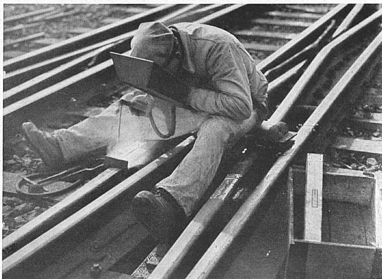
Unterhalts-Schweißarbeiten in einem SBB-Bahnhof
