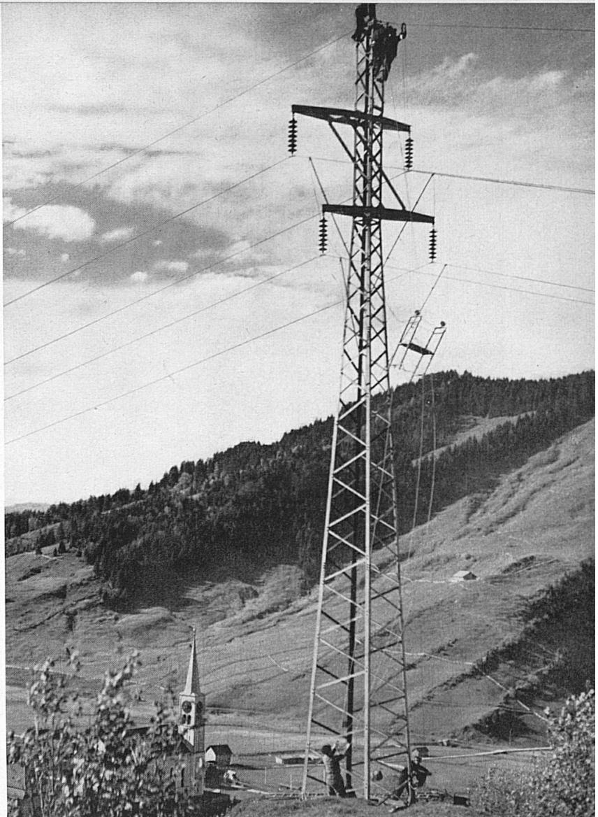
Unten: Nicht überall ist es möglich, mit dem Arbeitskorb an die «Flickstelle» zu gelangen. Ein Schwung, und ohne viel Worte zu verlieren, arbeitet der Monteur hoch in den Lüften, auf dem Hochspannungsdräht liegend, weiter.
