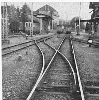
Vereinigte Bern-Worb-Bahnen. Der Eingang der Zunge besteht aus der normalen, alten Drehstuhlzunge, die an die anschließende Schiene angeschweißt worden ist.
