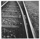
Durch den Einbau von Federzungen werden die Weichen um ca. 50% verbessert.
