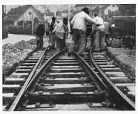
Chur-Arosa-Bahn. Einbau der Federzungenweiche beim Ausgang von Chur. Die Zungen sind aus Schienen gehobelt.
