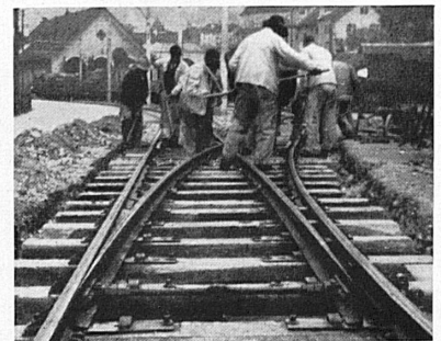
Chur-Arosa-Bahn. Einbau der Federzungenweiche beim Ausgang von Chur. Die Zungen sind aus Schienen gehobelt.
