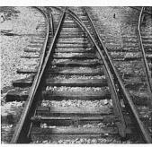
C.F. Bière-Apples-Morges. Infolge der Elektrifikation mußten die Weichen verstärkt werden. Es geschah dies durch Einbau von Federzungen.
