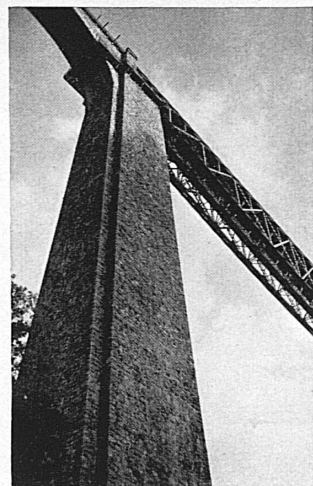
A sinistra: Il viadotto di Langwies della ferrovia Coira-Arosa, lungo m. 287 e alto m. 62 che attraversa il Plessur con un arco principale di m. 100. A destra: Uno degli arditi pilastri del grande viadotto sulla Sitter, lungo la ferrovia Lago di Costanza-Toggenburgo.
