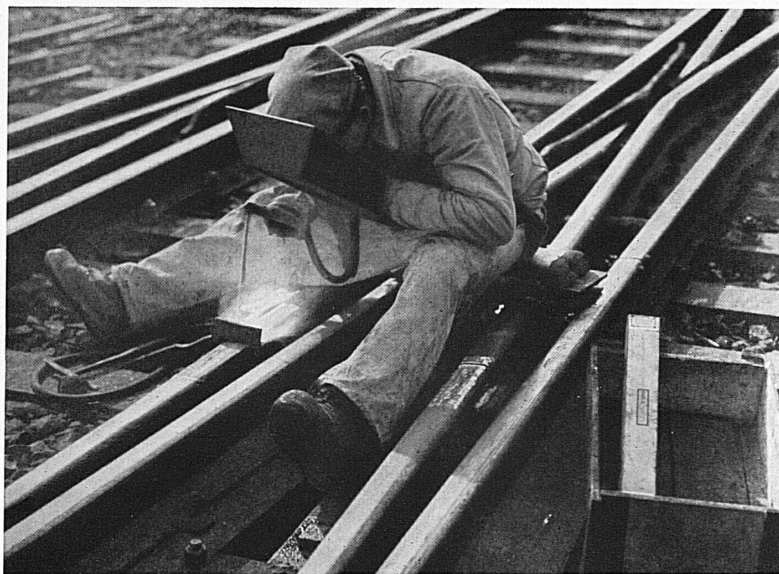
Unterhalts-Schweißarbeiten in einem SBB-Bahnhof
