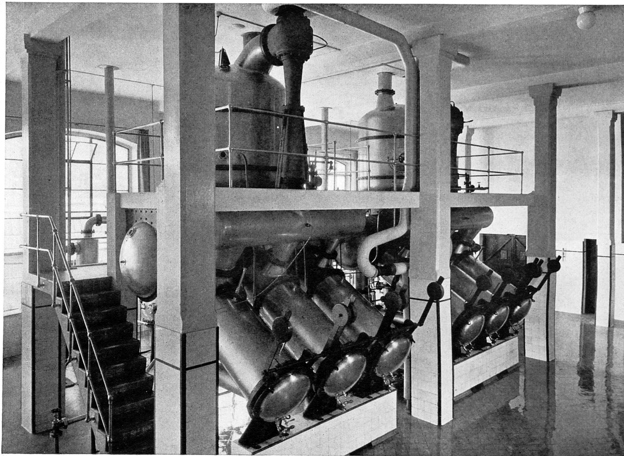
Kugelverdampfer einer Malzextraktionsanlage
