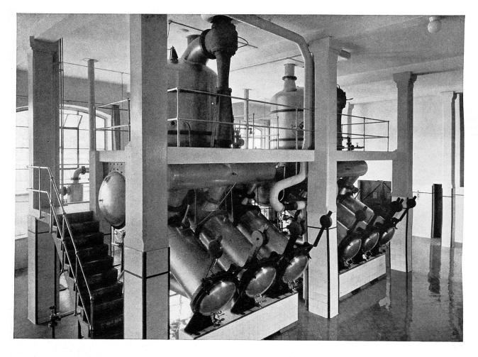
Kugelverdampfer einer Malzextraktionsanlage
