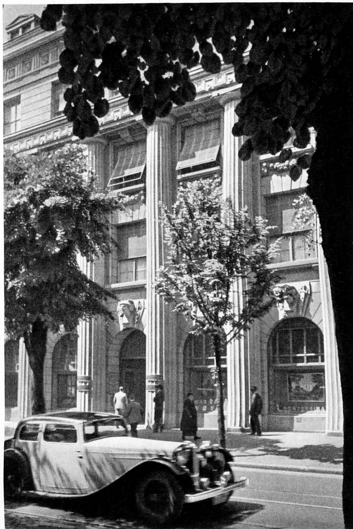
Bankgebäude an der Bahnhofstraße in Zürich
