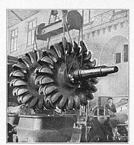
Rotor einer 15000-PS-Turbine Kraftwerk Amsteg der SBB
