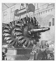
Rotor einer 15000-PS-Turbine Kraftwerk Amsteg der SBB
