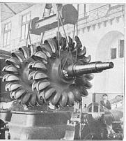
Rotor einer 15000-PS-Turbine Kraftwerk Amsteg der SBB.
