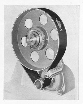
Antriebeiner Werkzeugmaschine durch endlos gewebten HEVALÖÏD-Riemen von 2 mm Dicke. Übersetzung 1:6,4
