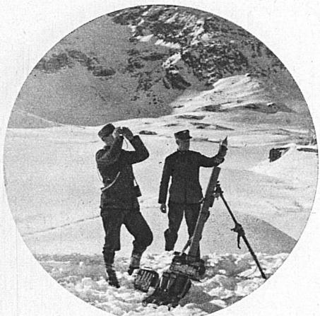
Threatening avalanches are artificially brought down on the Bernina Railway route — Détachement d'une avalanche artificiellement provoquée sur la voie du chemin de fer de la Bernina — Auf der Berninabahnstrecke werden Lawinen künstlich zur Loslösung gebracht
