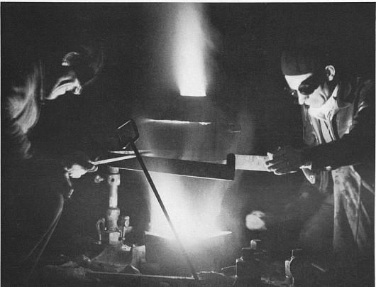
Oben: Im feuerfesten Tiegel wird die «Schweissportion» bereitgemacht Mitte links: Blitzschnell schiesst der Strahl in die Tonform (Mitte, kleines Bild) Unten: Der Schrottmeissel wird an
