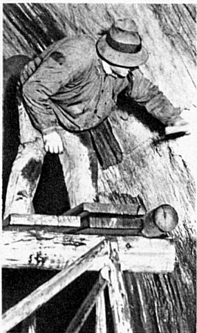
Richtig, wie der Hammer zuschlägt, löst sich ein ansehnliches Stück der Zementauskleidung
