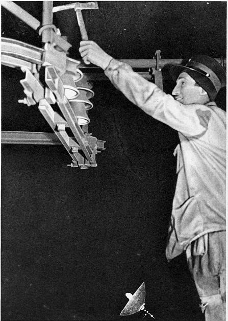
Beim Vorbeifahren an den Fahrleitungsträgern wird das Rohrgestänge abgeklopft. Klingt es dumpf, muss man es näher untersuchen
