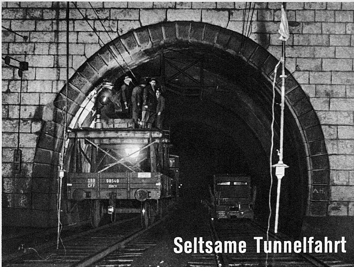
Einfahrt in den Tunnel. Im Vordergrund die Erdungsstangen, links der Kontrollzug mit einem hölzernen Aufbau, rechts die kleine Draisine des Fahrleitungs-monteurs
