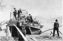
Verlegung eines Telephonkabels von 2620 m (in einer Länge) und 30 Tonnen Bruttogewicht durch den obern Zürichsee zwischen Rapperswil und Lidwil (Schwyz) — Etzelwerk – für die Schweiz. Bundesbahnen. 17. Aug. 1937. Ankunft des Verlegeschiffes in Rapperswil
