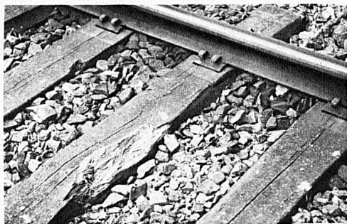
Une traverse vient d'être atteinte — Einer Schwelle brachte der Fels eine frische Wunde bei
