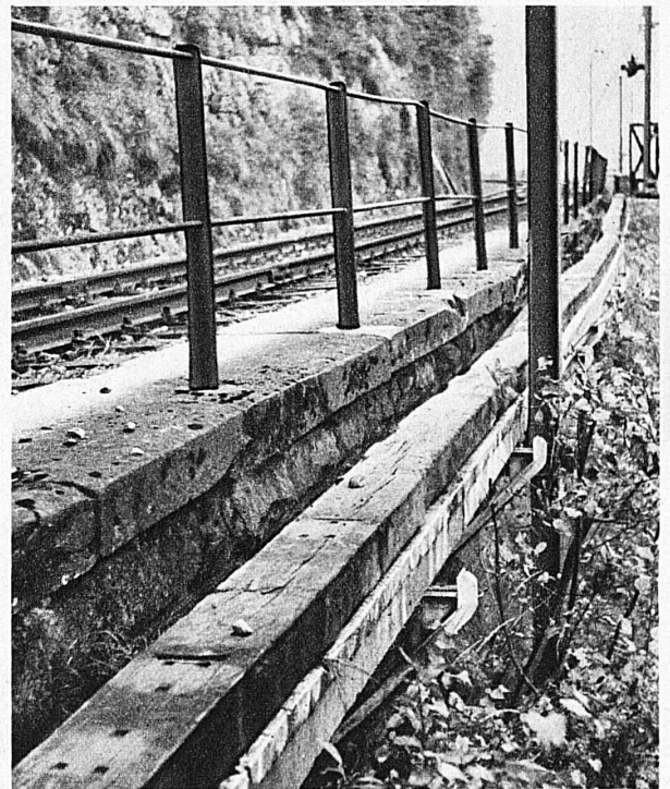
Links: Dieser stellenweis überhängende Fels hat seine Tücken. In launischer Unbeherrschtheit stösst er verwitternde Brocken ab, die den Bahnanlagen gefährlich werden können. Deshalb ist ein mitunter dreifacher Wall eiserner Schutzwände über den Geleisen errichtet worden. Mitte: Diese Schutzvorrichtungen sind, wie man sieht, durchaus nicht überflüssig. Sie stellen aber nicht die einzigen dar... Rechts: An dieser romantischen Bahnstrecke wäre es nämlich gewagt gewesen, die Übertragungsleitung wie üblich frei über weitspannende Masten zu führen. So sah man sich genötigt, sie in einen Betonkanal zu verlegen — A gauche: En certains points, la roche surplombe, et cela n'est pas sans danger. Rongés par les intempéries, des blocs se détachent de temps à autre, et risqueraient de mettre le chemin de fer en péril si une triple barricade de fer n'avait été édiflée au-dessus de la voie. Au milieu: Ainsi qu'on en peut juger, ces mesures de protection ne sont pas inutiles. Mais elles ne sont pas les seules... A droite: En cet endroit du tracé, qui traverse une région des plus romantiques, c'eût été une imprudence que d'installer la conduite de transmission, comme c'est l'usage, sur des mâts spéciaux; il a fallu la placer dans un canal bétonné
