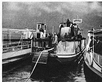
Verlegung eines Telephonkabels im Luganersee zwischen Morcote und Brusino für die Post- und Telegraphenverwaltung. November 1934
