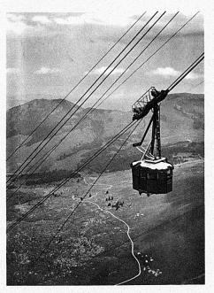
Für die Säntis-Schwebebahn lieferten wir die beiden Zugseile in der patentierten Machart TRU-LAY-BRUGG und das Hilfsseil in einem Gesamtgewicht von 18 Tonnen, ferner 7200 m Stahldrahtseil 13 mm Durchmesser für die Hochspannungsleitung von der Schwägalp auf den Säntis.
