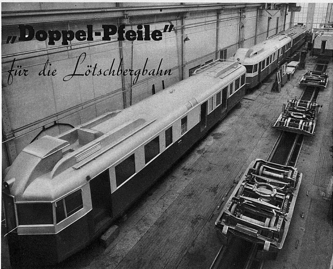
Die neuen «Doppelpfeile» der Lötschbergbahn und deren Drehgestelle, die nach einer besonderen Konstruktion ein Einschwingen der Achsen in die Kurven gestatten — Les nouvelles «flèches doubles» du chemin de fer du Lötschberg et leurs bogies. Ceux-ci sont d'une construction spéciale permettant aux essieux de se mettre en position radiale dans les courbes
