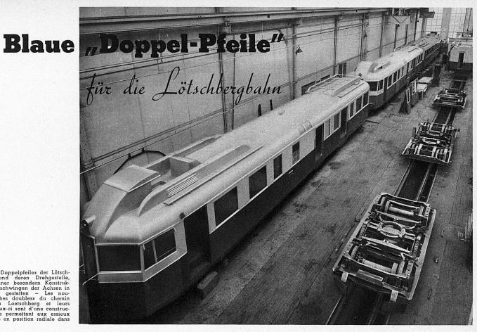
Die neuen «Doppelpfeile» der Lötschbergbahn und deren Drehgestelle, die nach einer besondern Konstruktion ein Einschwingen der Achsen in die Kurven gestatten – Les nouvelles «fleches doubles» du chemin de fer du Loetschberg et leurs boggies. Ceux-ci sont d'une construction spéciale permettant aux essieux de se mettre en position radiale dans les courbes
