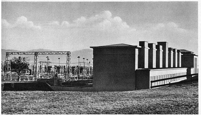
Die ausgeschachtete Erde vor der Stirnwand der Etzelwerkzentrale weist darauf hin, dass das Gebäude vergrössert werden kann. Nach einer Erweiterung lassen sich noch zwei Maschineneinheiten von je 24,000 PS unterbringen Les fouilles operées en face de la centrale de l'usine de l'Etzel indiquent que cette dernière pourra encore être agrandie.
