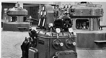
der Maschinenhalle. Vorn ein Regulator, der bei Störungen die ihm angeschlossene
