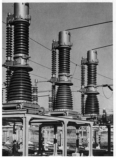
Die neuen ölarmen Schalter in der Freiluftanlage. Sie sind weniger feuergefährlich und zeichnen sich durch grosse Schaltleistung und Schaltgeschwindigkeit aus Les nouveaux interrupteurs à faible quantité d'huile des installations à ciel ouvert. Ils sont moins exposés au danger d'incendie et se distinguent par une puissance d'opération supérieure et une grande rapidité
