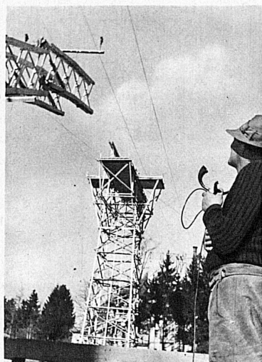
Der Zimmerpolier beobachtet den Fortgang der Arbeiten und erteilt in das Mikrophon exakte Anweisungen zum Einfahren der Holzsegmente — Le contremaître charpentier surveille la marche des travaux et donne, au microphone, des indications précises pour l'amenée des segments
