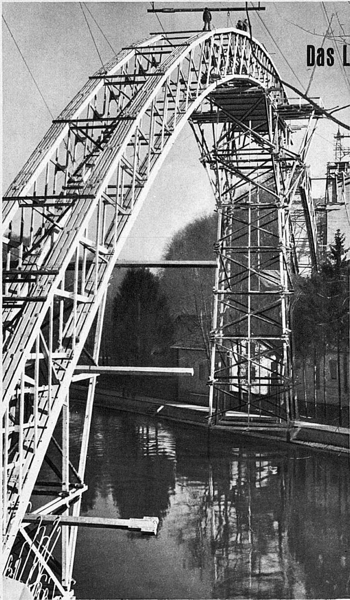
In kühnem Bogen schwingen sich die beiden ersten Binder über den Aarefluss. Im Vordergrund der linksseitige Betonpfeiler, am andern Ufer (Bogenmitte) der sogenannte Montageturm, im Hintergrund rechts die gegenüberliegenden Betonpfeiler — En un arc audacieux, les deux premières fermes s'élèvent au-dessus de l'Aar. Au premier plan la pile de béton de gauche, de l'autre côté (au milieu de l'arc) la tour dite de montage, au fond, à droite, les piles de béton se trouvant en face
