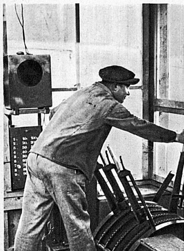
Blick in die Führerkabine. Der Mann an den Hebeln reagiert genau auf die Lautsprecherbefehle und hilft mit am Gelingen der schwierigen Arbeiten — Dans la cabine de commande. Les ordres sont transmis au microphone. L'homme préposé aux leviers suit ces ordres exactement et contribue ainsi pour sa part à la réussite des travaux. (Dans cette cabine de verrière il y a deux conducteurs de travaux et deux postes d'interrupteurs)
