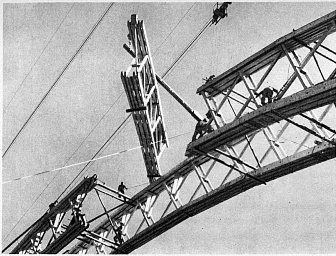
(Tele-Aufnahme) Der Bogen wird geschlossen. Dank der guten Ingenieur-Vorarbeiten, der soliden Zimmermannsarme, der Befehle des Poliers und der Führer in der Kabelkabine gelingt das Einsetzen des Paßstückes glänzend — (Prise de vue au téléphot) L'arc est fermé. Grâce à l'irréprochable travail préparatoire des ingénieurs, aux robustes bras des charpentiers, aux ordres du contre-maitre et aux conducteurs de travaux dans la cabine, la mise en place de la dernière pièce réussit parfaitement
