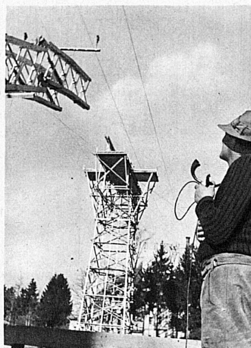
Der Zimmerpolier beobachtet den Fortgang der Arbeiten und erteilt in das Mikrophon exakte Anweisungen zum Einfahren der Holzsegmente — Le contremaître charpentier surveille la marche des travaux et donne, au microphone, des indications précises pour l'amenée des segments
