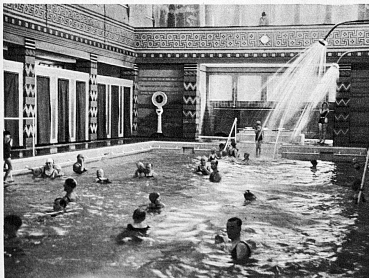
Im Hallenschwimmbad Ragaz, das von der unerschöpflich reichen Therme gespeist wird - La piscine de Ragaz, alimentée par une source thermique inépuisable
