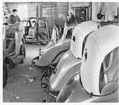
Montage des sièges et des capotes – Montage der Verdecke und Polsterung
