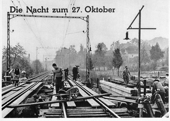
Am Nachmittag des 26. Oktober: Dott, wo die neue Eisenbahnbrücke dem Bahnkörper eingefügt werden soll, sind Hilfsbrücken eingebaut, über welche die Züge nur im 10-Kilometertempo schleichen dürfen
