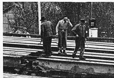
Hier sieht man die neue Brücke aus der Vogelperspektive. Schon am Nachmittag hat man die Schwellen aufgelegt, welche am nächsten Morgen die Geleise tragen sollen
