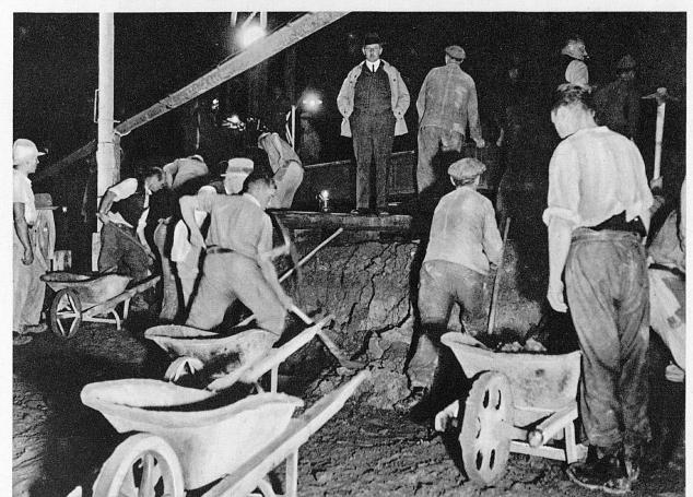
11.45 Uhr. Die härteste Arbeit der Nacht – im wahrsten Sinne des Wortes – beginnt, die Abtragung des Erdkerns, der den Pickeln und Spaten erbitterten Widerstand entgegenbringt. Die Erde birgt mehr Stein, als man vermutet hat, der zähe Lehm trotzt selbst den Brechstangen
