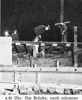
4.30 Uhr. Die Brücke, noch schienenlos am Ziel! Rechts sieht man den Hohlraum unter den Geleisen des Bahnkörpers, der unterklotzt werden muss
