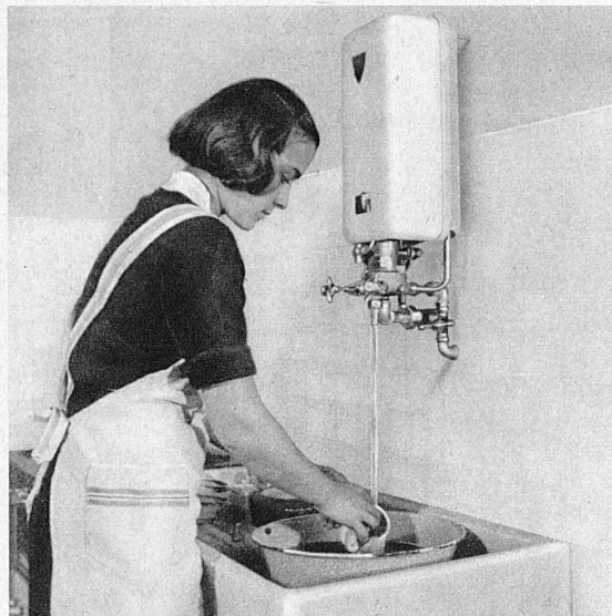
Der billige Gas-Kleinautomat spendet für die Küche reichlich heisses Wasser zu jeder Zeit. Le petit chauffe-eau instantané à gaz est bon marché et fournit en tout temps toute l'eau chaude nécessaire à la cuisine.
