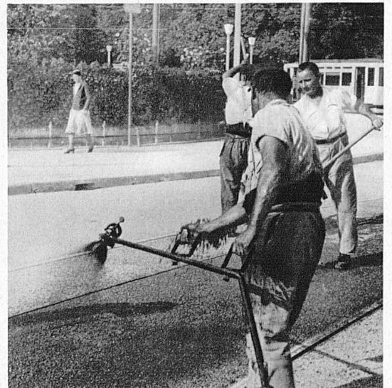
Schweizer Gaswerksteer dient zum Strassenbau und als Rohstoff für unsere chemische Industrie. Le goudron suisse des usines à gaz sert dans la construction de routes et de matière première à notre industrie chimique.
