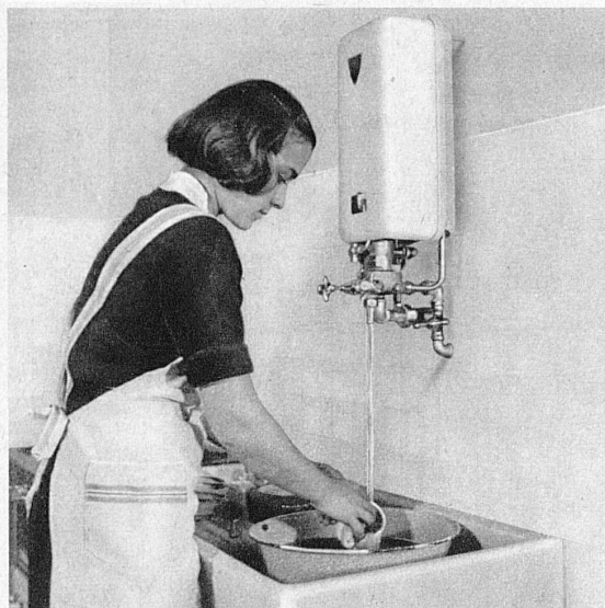
Der billige Gas-Kleinautomat spendet für die Küche reichlich heisses Wasser zu jeder Zeit. Le petit chauffe-eau instantané à gaz est bon marché et fournit en tout temps toute l'eau chaude nécessaire à la cuisine.
