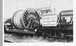
Verlegung eines Telephonkabels von 2620 m (in einer Länge) und 30 Tonnen Bruttogewicht durch den obern Zürichsee zwischen Rapperswil und Lidwil (Schwyz) — Etzelwerk – für die Schweiz. Bundesbahnen. 17. Aug. 1937. Das speditionsbereite, auf eiserner Spezialtrommel aufgewickelte Kabel auf dem Fabrikgeleise der Kabelwerke Brugg AG.
