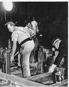
Die neue Weiche an Ort und Stelle. Der Bahnmeister misst den Achsabstand – La nouvelle aiguille est en place. Le chef mesure l'écart des essieux
