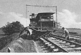
Machine à dégarnir et cribler le ballast des voies de chemins de fer
