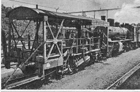
Machine à piocher, ameublir et désherber le ballast des voies de chemins de
