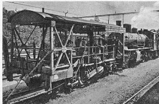
Machine à piocher, ameublier et désherber le ballast des voies de chemins de fer
