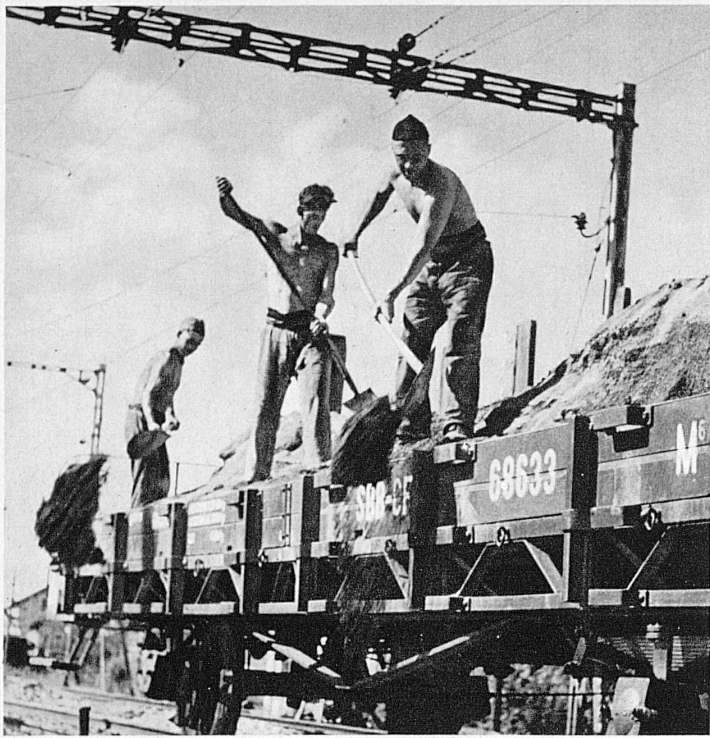
Der Untergrund der neuen Geleiseanlage muss abgedichtet werden. Hier sieht man, wie der Sand herangeschafft wird — Amenée de sable pour ameublir le sol
