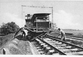
Machine à dégarnir et cribler le ballast des voies de chemins de fer **Syst. Scheuchzer**
